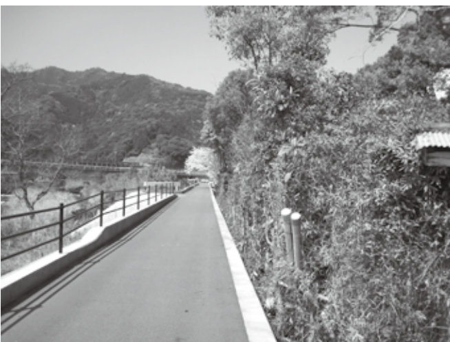
支障になる樹木を伐採した道
